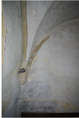
Le départ de l'ancienne voûte de la chapelle St Franchy
