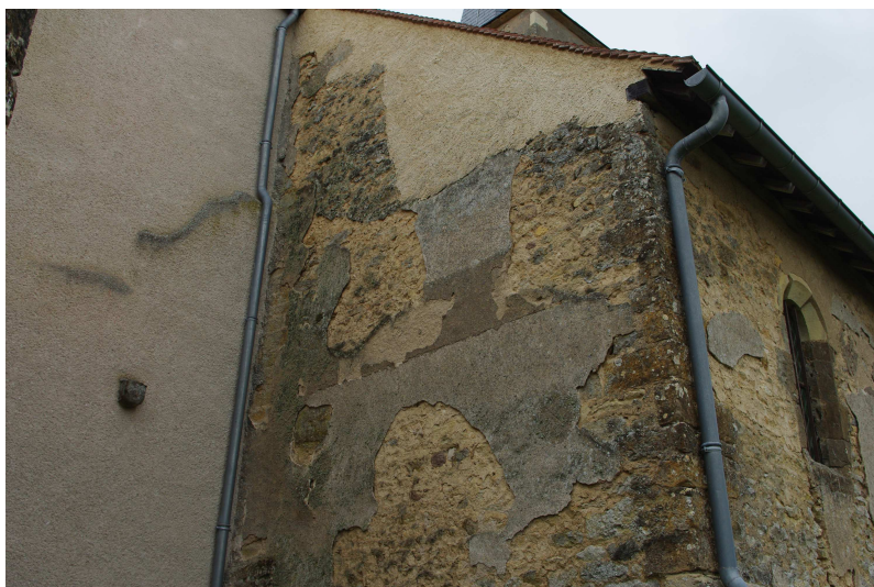
Ci-contre le mur est de la chapelle St Franchy avec le contrefort pris dans la maçonnerie, les vestiges de la litre funéraire et l'arase du premier mur de la nef
